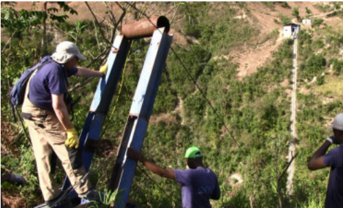
Blick von der Druckleitung zum Aufzug.
