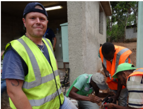
Joël Dondelinger vor der neuen Trafostation.
