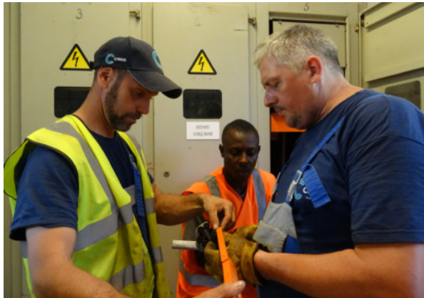
Henri et Joël, finalisation des travaux près du plan incliné.
