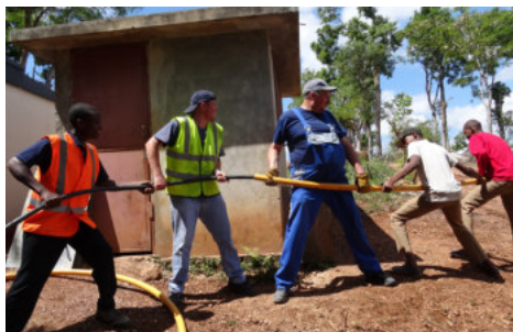
Pose du dernier câble à Viala.
