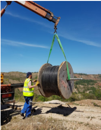
Transport der Kabeltrommel.
