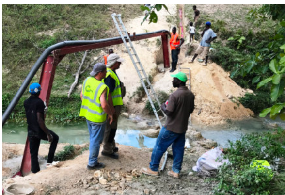
Viala, construction d'un pont au-dessous de la rivière.
