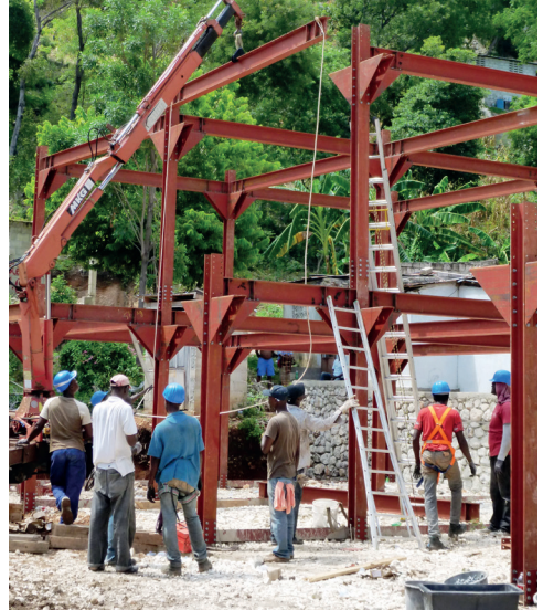
Construction de l'école EHL à Carrefour
