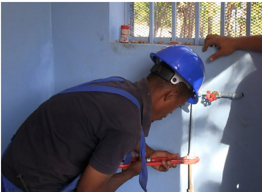
Unser Partner repariert den Wasserkiosk Notre partenaire repare le kiosque d'eau
