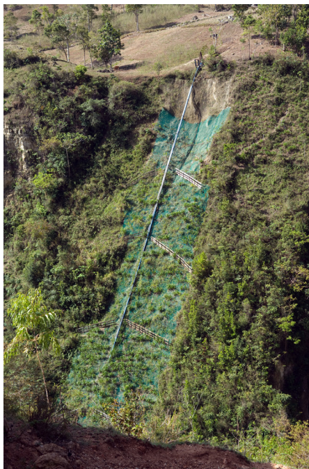
La ligne de pression alimentant la turbine
