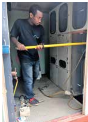
Travaux sur la cellule à haute tension
